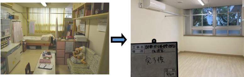
これまでサッシの隙間から風や埃が入り込み、冬は結露に悩まされていた保健室が、ペアガラスサッシと断熱材入りの壁、フローリング床に改修され、清潔で快適な空間になりました。
